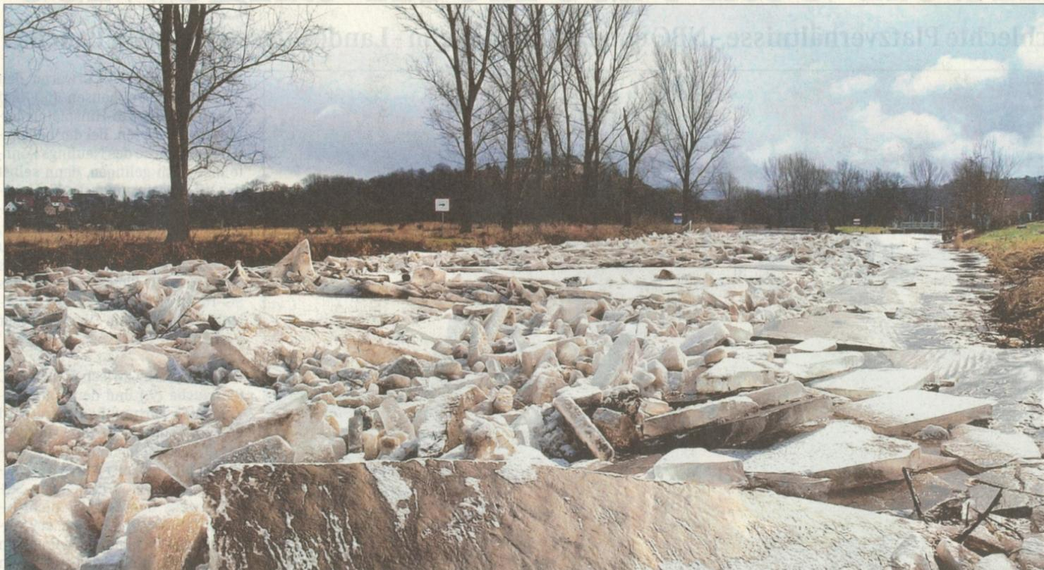
Packeis auf der Unstrut: Vor dem Wehr bei Tröbsdorf stauen sich die Schollen. Die Barriere hat den Wasserspiegel oberhalb des Wehres um etwa 30 Zentimeter ansteigen lassen. Gefahr besteht nach Auskunft des Landesbetriebes für Hochwasserschutz derzeit allerdings nicht. Man be-
