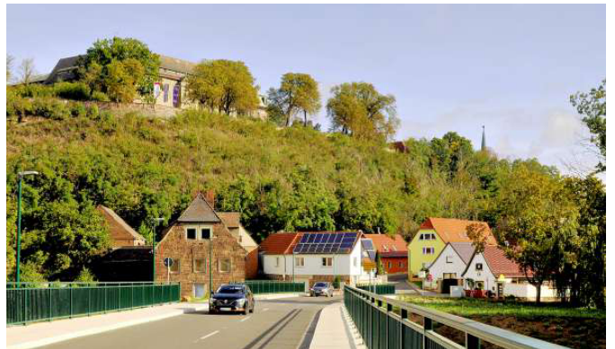
Zwei Jahre nahmen die Bauarbeiten für die neue Brücke über die Unstrut in Anspruch. Heute ist das Viadukt für das Ortsbild beinahe ähnlich prägend wie das Schloss hoch oben auf dem Burgberg. FOTOS (7); ANDREAS LÖFFLER
