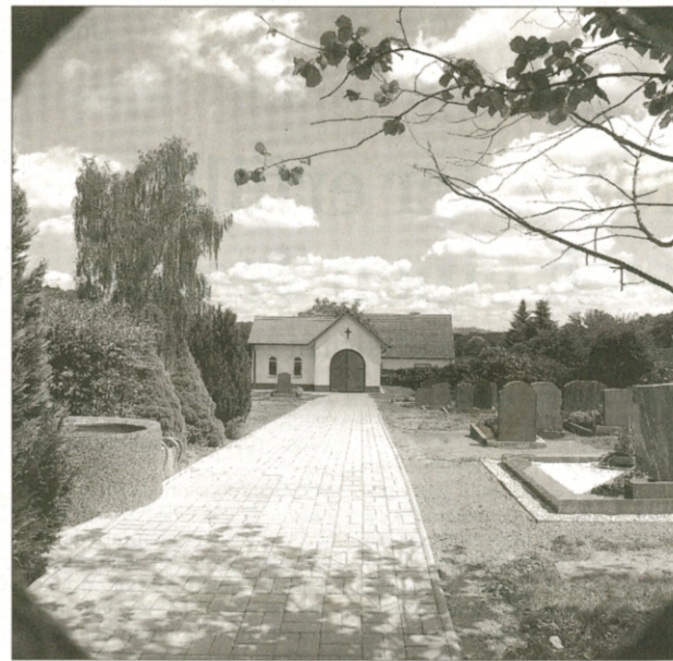
Die neue Trauerhalle auf dem Friedhof in Tröbsdorf wurde am Sonntagnachmittag ihrer Bestimmung übergeben.
