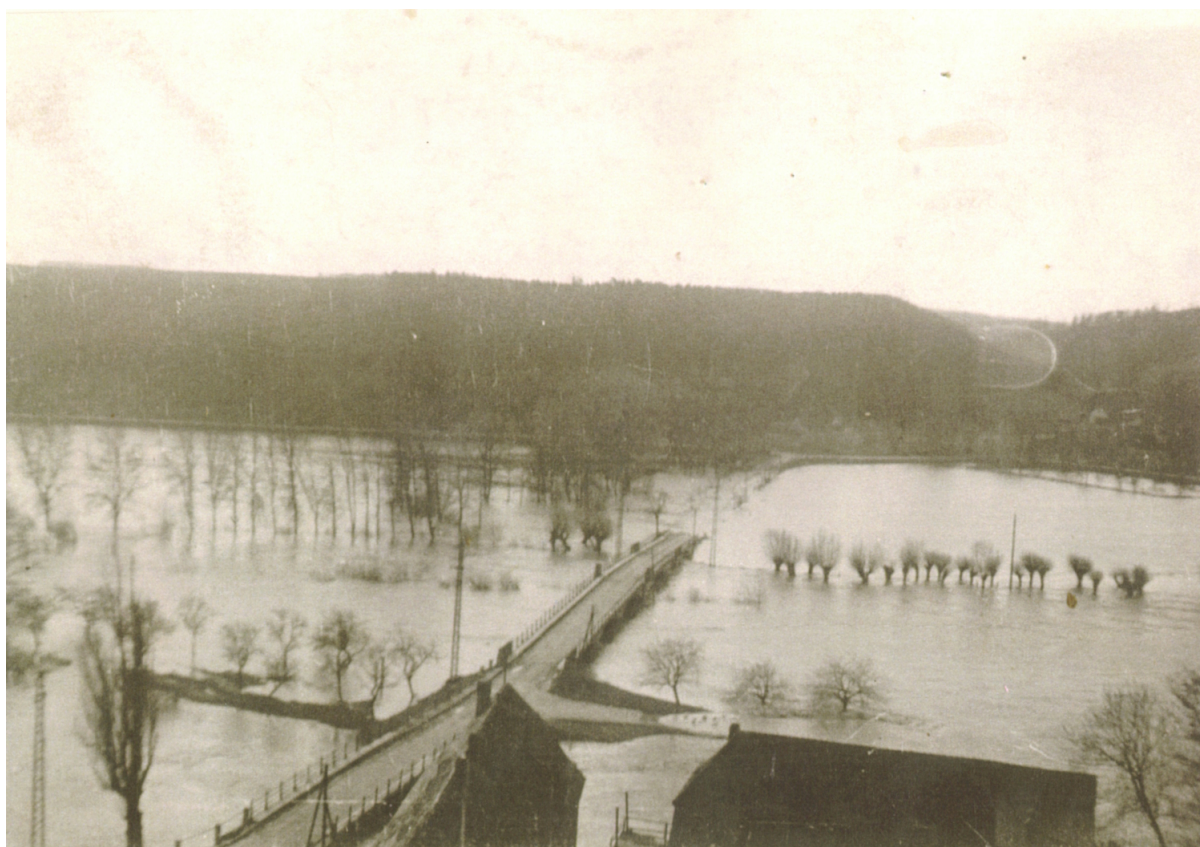
Hochwasser 1947 / Blick vom Schloss auf die Unstrutbrücke
