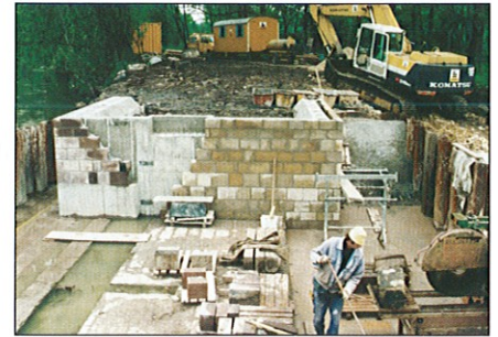
Linkes Widerlager des Wehr
