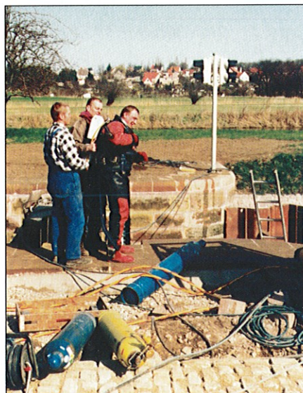
Taucher vor dem Einstieg zum Abbrennen der Stahlspundwände (links). Planschnitt an den Holztores (mitte). Bauarbeiten am oberen Warteplatz (rechts).
