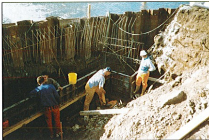
Gründung des rechten Widerlagers (links). Das rechte Wehrwiderlager mit Übergang zum Untergraben (rechts).
