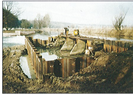
Die Baugrube für die Grundschießenanlage.
