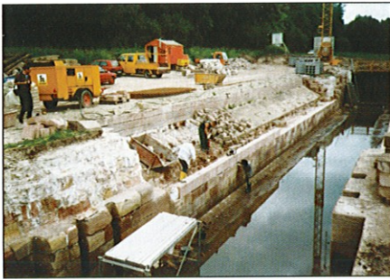
Abbruch verschlissener Bauwerksteile an der Schleuse (links). Neuerlegung der Abdeckplatte auf dem Unterhaupt (mitte). Schleuse Tröbsdorf nach der Fertigstellung (rechts).
