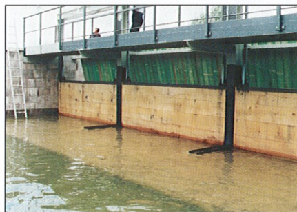
Fertige Schützenanlage mit Notverschluss
