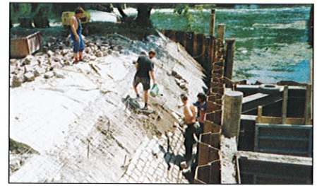
Pflasterarbeiten am Untergraben.
