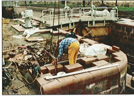
Abbruch verschlissener Bauwerksteile an der Schleuse (links). Neuerlegung der Abdeckplatte auf dem Unterhaupt (mitte). Schleuse Tröbsdorf nach der Fertigstellung (rechts).
